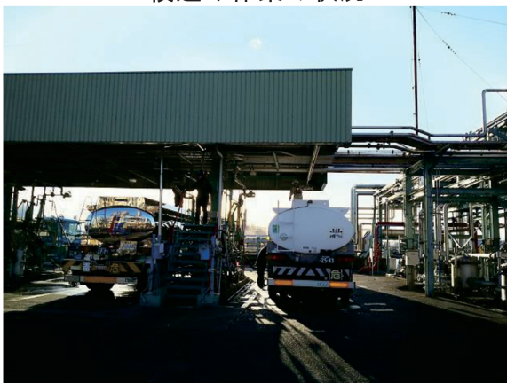
積込み作業の状況
