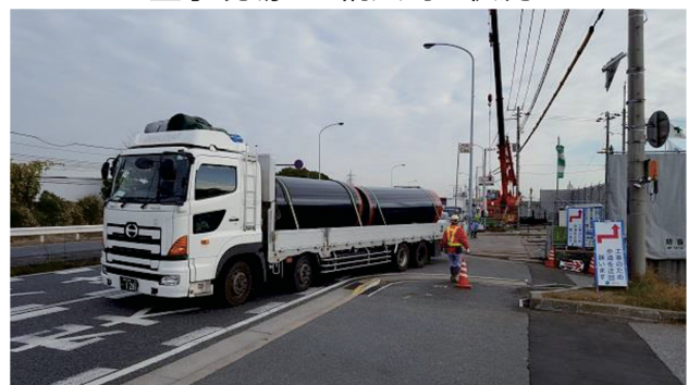
工事現場への納入時の状況
